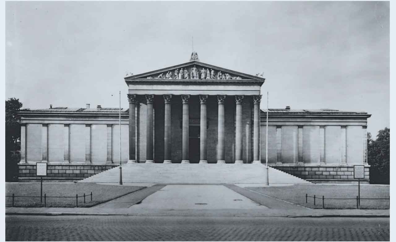
Abb. 14: Neue Staatsgalerie am Königsplatz (ehem. Kunst- und Industrieausstellungsgebäude, später Secessionsgebäude), 1932
